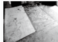
大分市 水害被災後復旧手順 写真
